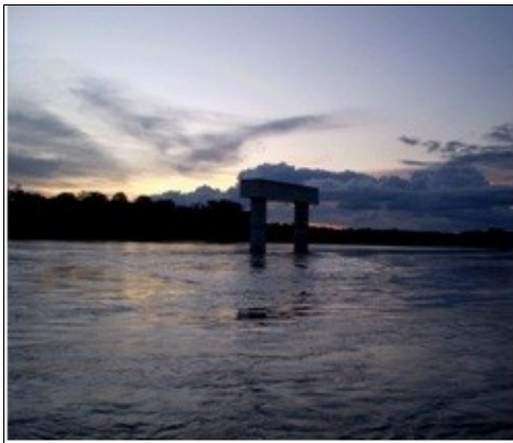
Enero de 2010: sólo estaban contruidos los dos pilares
