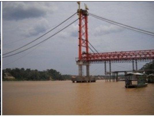
Septiembre (construidas las torres y los accesos)
