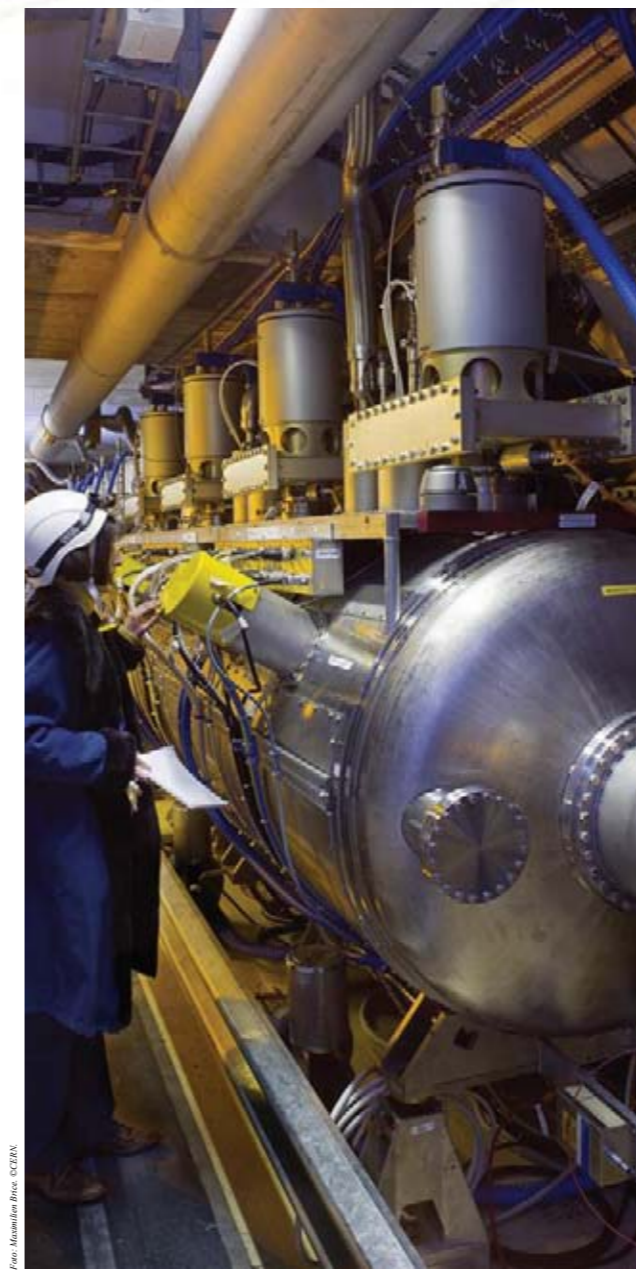
Cavidad para la superconducción de las radiofrecuencias del LHC, en el túnel del LHC.
