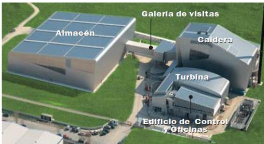
**Figura 3.** Planta de biomasa para la combustión de paja en Sangüesa
