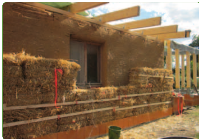
Aislamiento exterior con paja
